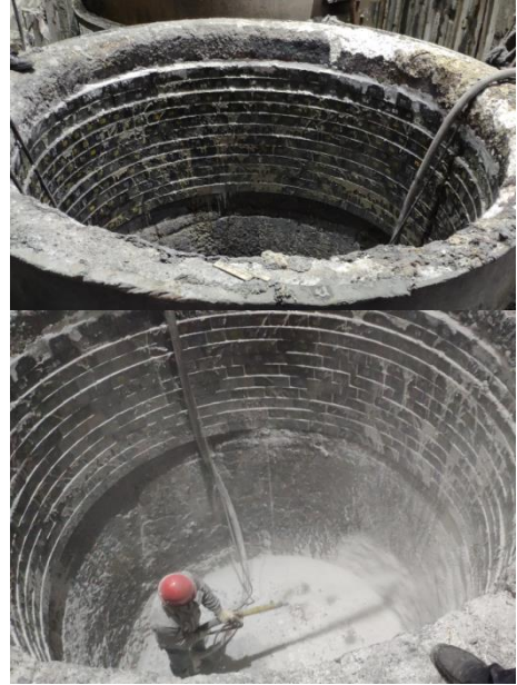
钢包冷修耐火层料喷补
