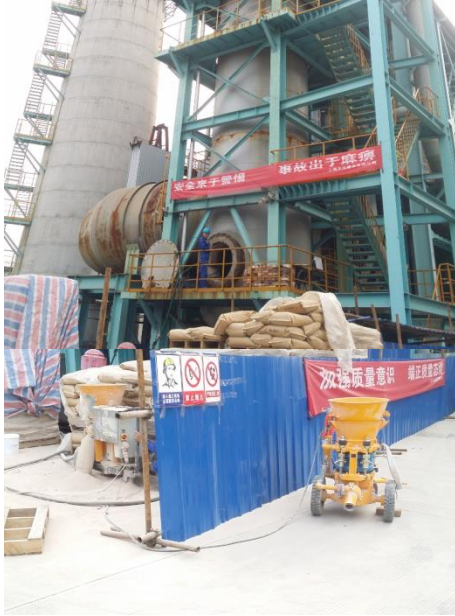
化工高炉耐火内层喷涂修补
